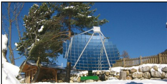
Lavarone (TN) - settore residenziale STG C12
