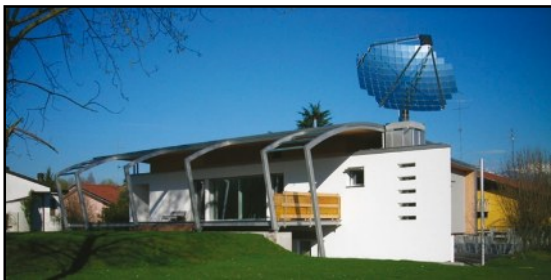
Pordenone - settore residenziale STG C12
