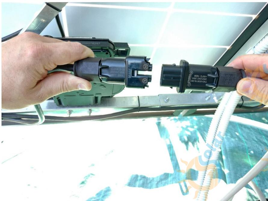
INSTALLARE IL CONNETTORE IN DOTAZIONE SUL CAVO DI ALIMENTAZIONE E COLLEGARE I 2 CONNETTORI
